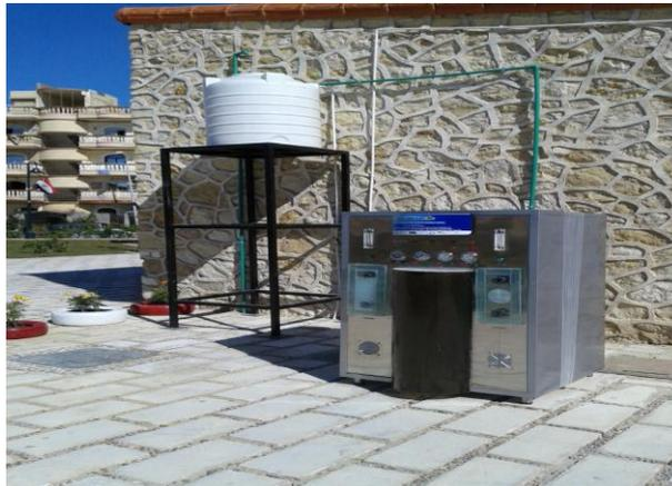
شكل (28) صورة وحدة معالجة المياه الرمادية
