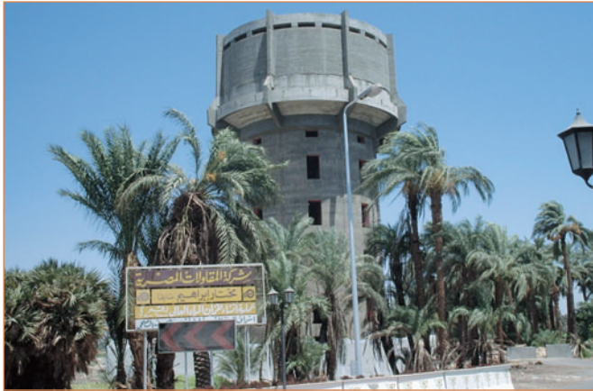
خزان مياه تحت الإنشاء - مدينة قنا
