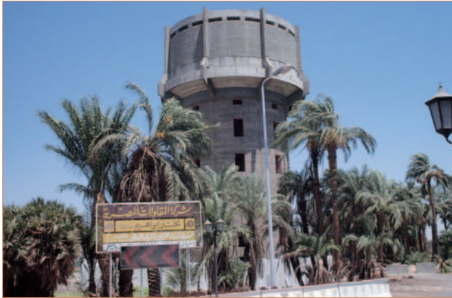
خزان مياه تحت الإنشاء - مدينة قنا
