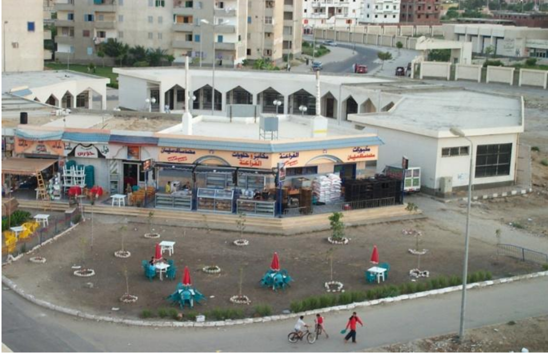
صورة - ١١ - سوق المجاورة الثانية بالحي الثاني
