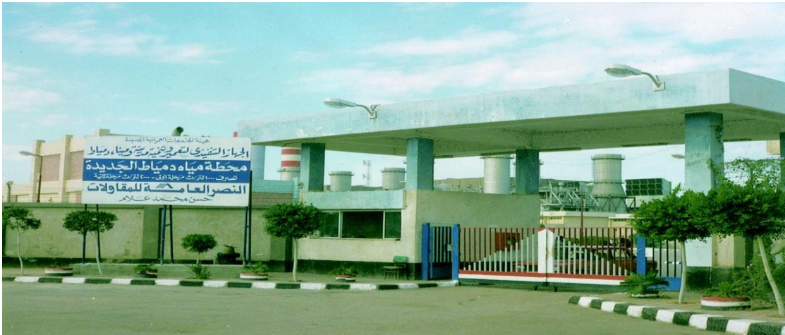
صورة ٢ - محطة مياه دمياط الجديدة
