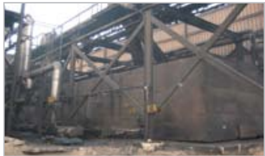
صورة (١٣-٥) المشروع قبل التنفيذ - وحدة صهر القار
