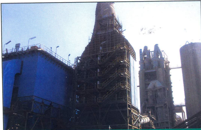
بعد تنفيذ المشروع: المبادل الحراري والمرشح النسيجي
